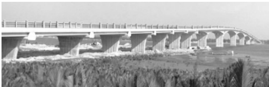
Hình 1. Công trình cầu Cửa Đại sử dụng hệ kết cấu BTCT và BTCT ứng lực trước.
