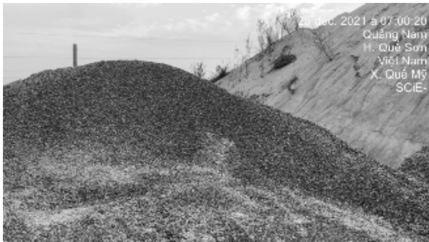
Hình 3. Vật liệu đầu vào cho bê tông gồm cát, đá được tập kết tại bãi lộ thiên.
